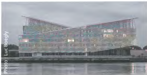
▲ Métropole Rouen-Normandie, Jacques Ferrier Architecture : l'enveloppe photovoltaïque n'est, là, pas démonstratrice. Il n'est pas possible de distinguer l'écaïlle de verre photovoltaïque de celle qui ne l'est pas.
