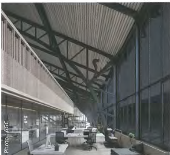
▲ Avec les vitrages électrochromes, il n'est pas question de produire de l'énergie, mais de gérer les apports solaires passifs et le confort des occupants en obscurcissant plus ou moins les vitrages. Un grand principe de la façade active. Halia, d'AGC Glass Europe
