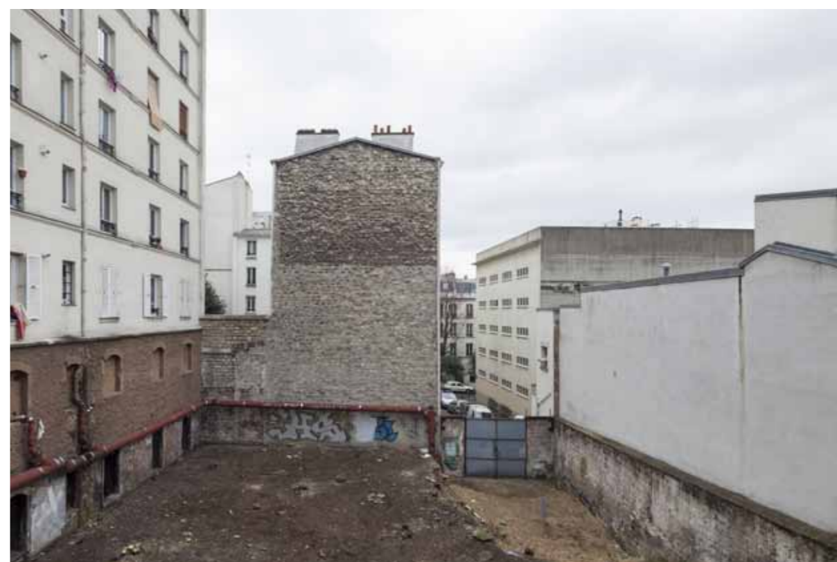
Vue depuis la terrasse haute
