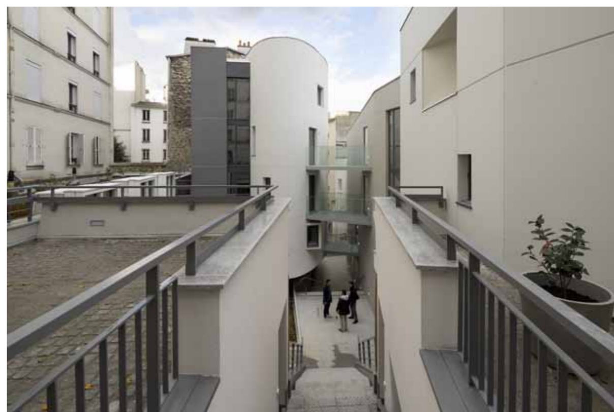
Vue depuis la terrasse haute
