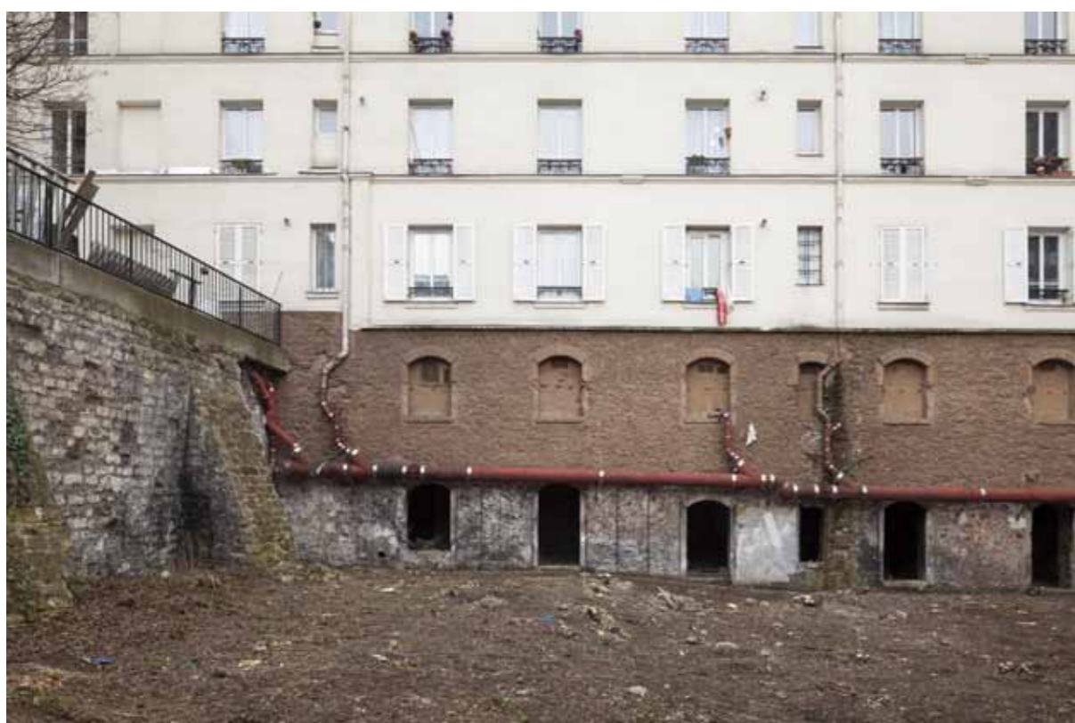
Vue des contreforts et des caves du 36 rue Ramey
