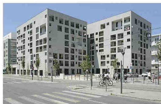
Habitat 86 logements en accession à Lyon VIII e Maître d'ouvrage: Nexity Apollonia Architecte: Eric Lapiere Experience
