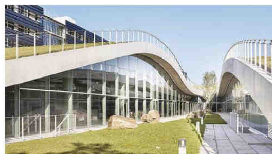
Lieux d'activité Pôle scientifique et technique Paris Est à Marne-la-Vallée (Val-de-Marne) Maître d'ouvrage: Ministère de l'Ecologie Architecte: Jean-Philippe Pargade
